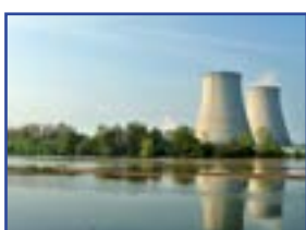
Contrôle d'accès aux installations nucléaire
