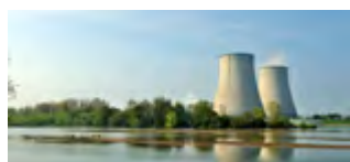
Réseaux de surveillance des sites nucléaires
